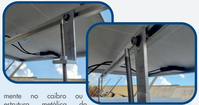
mente no caibro ou estrutura metálica do telhado, já que a haste possui ranhuras de ambos os lados com este propósito.
