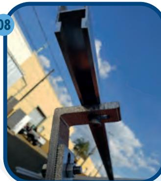
Abaixo o suporte corretamente instalado. O trilho da FotoFix poderá ficar em balanço de até 0,6 metros sem prejudicar a segurança da instalação dos painéis fotovoltaicos.
